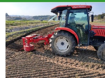
溝掘り機での額縁明渠施工
